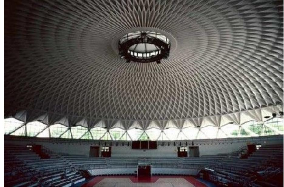
A gauche: Détail de la partie centrale de la diatomée *Arachnoidiscus*. A droite: couple de béton renforcée par des nervures pour le palais des sports de Rome, conçu par Pier Luigi Nervi.
